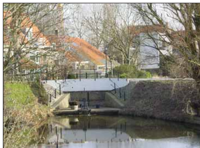
Cultuurhistorische elementen: electriciteitsmast en sluisje
