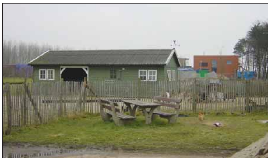
Stallen en uitloopweiden
